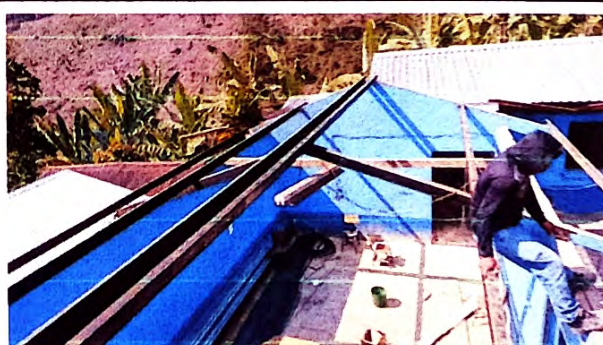
Foto 6: Destechando las láminas y costaneras de metal en mal estado de la bodega.
