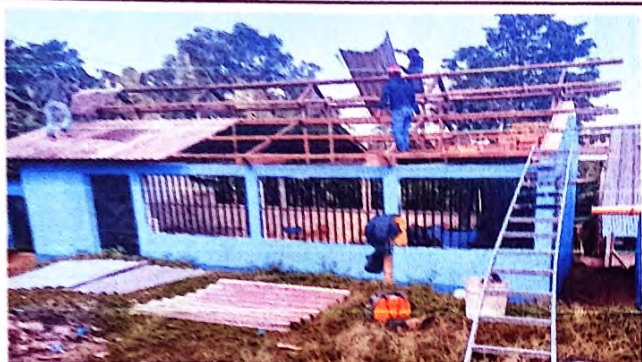
Foto 1: destechar las láminas viejas y costaneras de madera en mal estado del aula 1.
