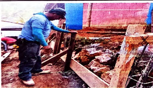
Foto 5: colocando el cimient y levantamiento de la estructura con materiales de piedra del muro perimetral.
