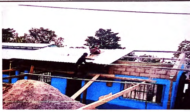
Foto 4: colocando las láminas y costaneras del aula 2.
