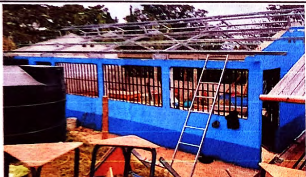
Foto 3: colocando las costaneras para el techo del aula 1.
